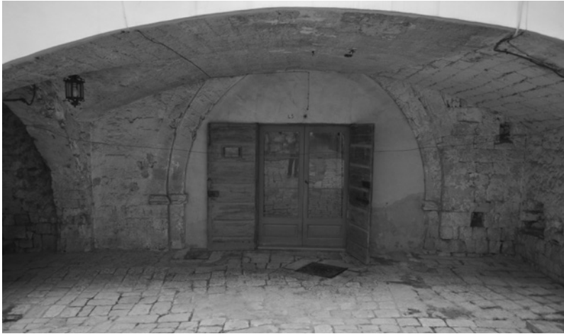
Fig. 6. Torre di sudest, prospetto Sud, arco a doppia ghiera lunata (Foto di Paolo Perfido).
